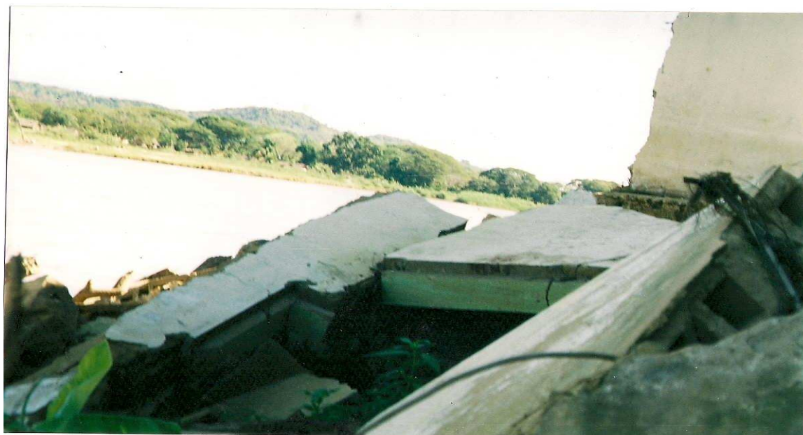
Photo N°9 Ecole de la commune rurale d'Ankatafa détruite par l'inondation du Sambirano
