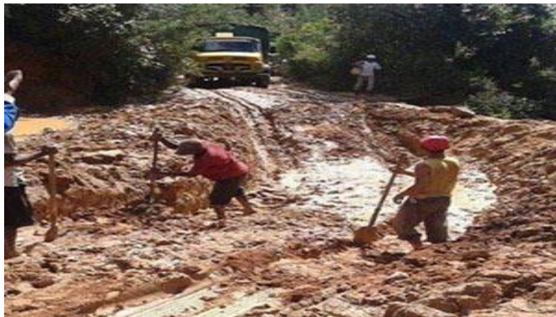
Mauvaise état de la route qui mène vers Tsiazompaniry
