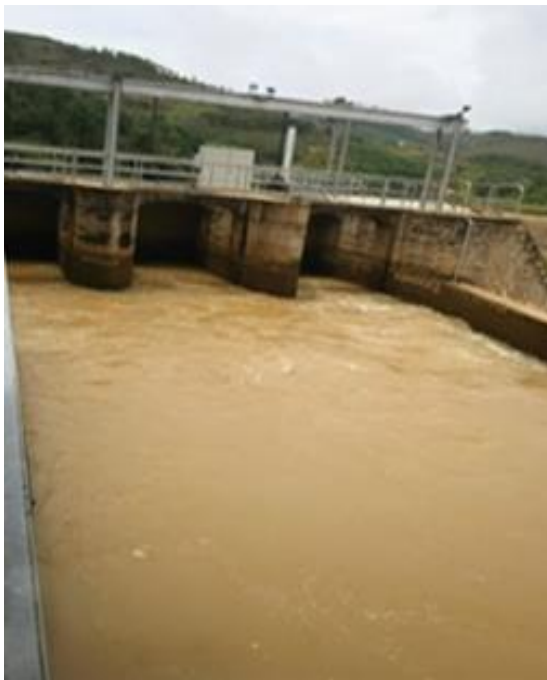
Central hydroélectrique d'Antelomita
