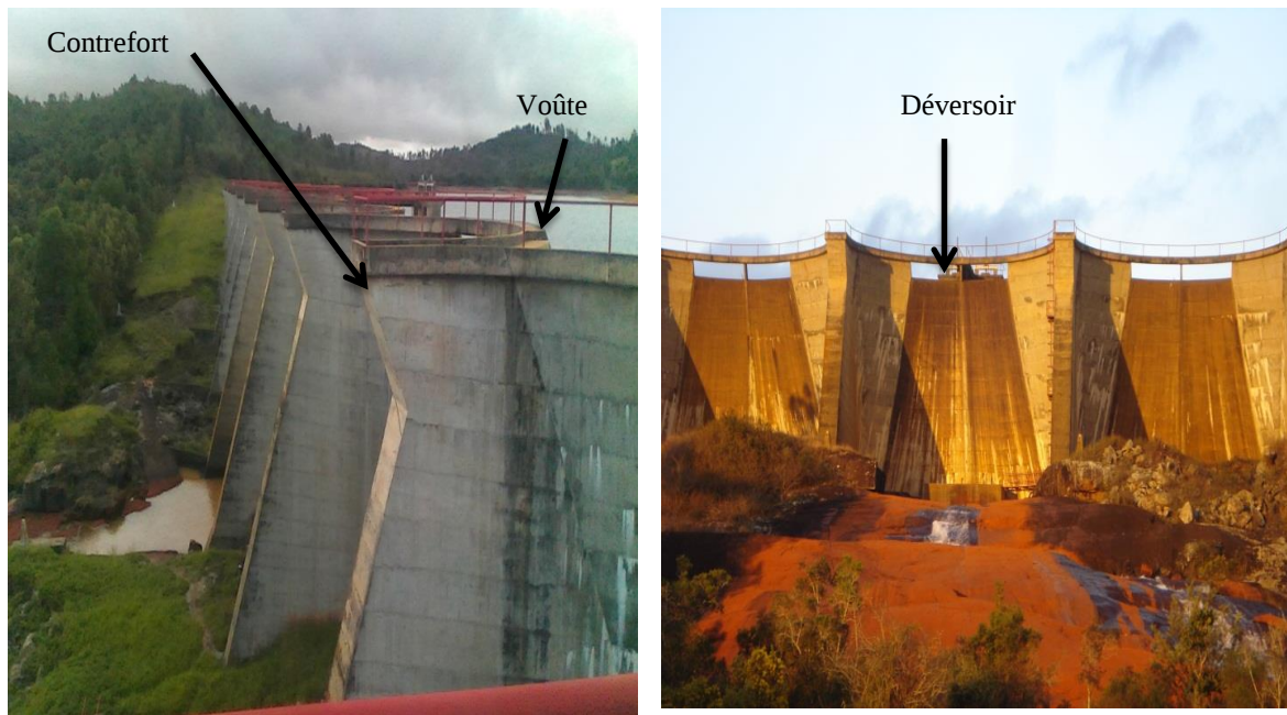
Figure 9: Les deux barrages de Tsiazompaniry
