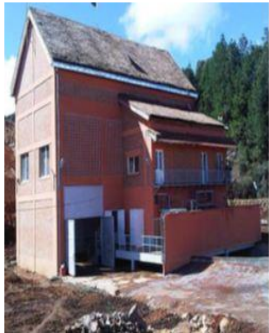
Central hydroélectrique d'Henri FRAISE (TIANA RAZAFITSIMBA ,2014)
