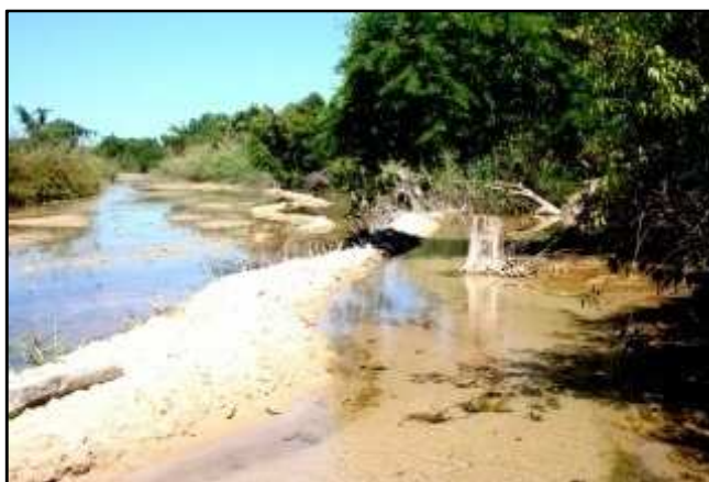
Photo 4 : Diguettes en sable fortifiées par des tiges et feuilles mortes dans le lit d'un cours d'eau
